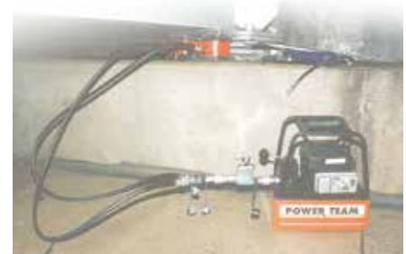
Polttomoottorikäyttöinen PG303pumppu apuna nostotyössä
