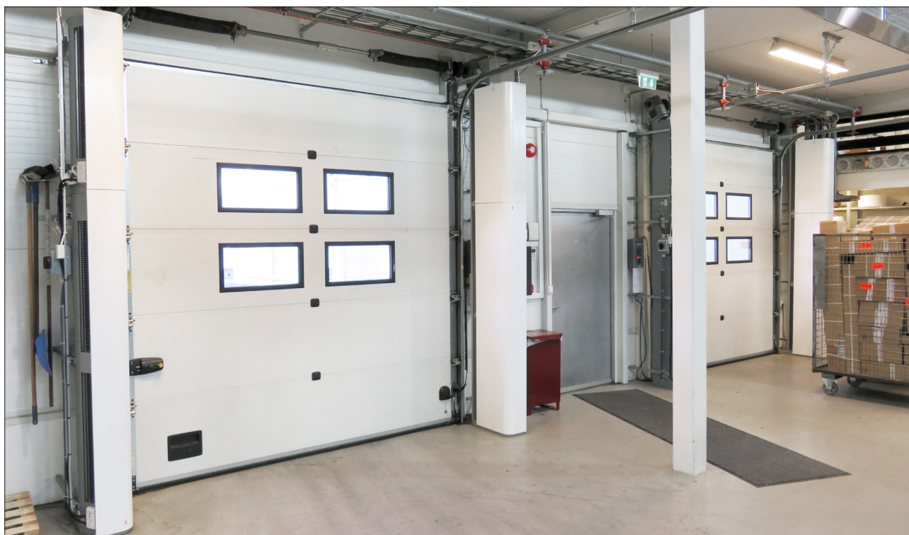
Pystyasenteisia Pamir 5000 torneja. Kojeden lattia ja yhteenliitoksessa käytetään PA4JK pystyasennussarjaa.
