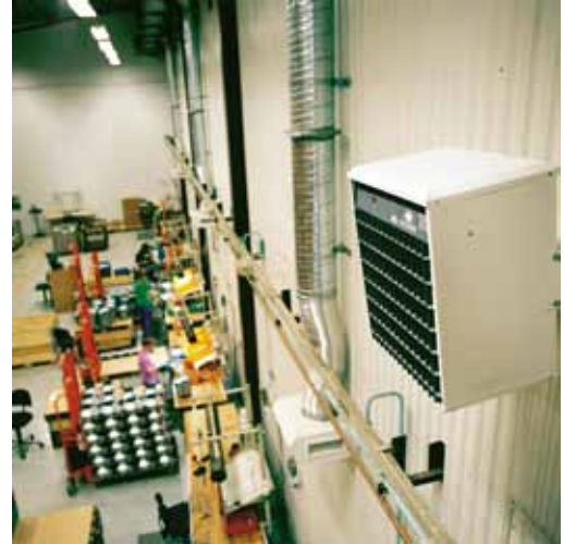
Panther 20-30 -lämpöpuhallin soveltuu suurten teollisuustilojen lämmitykseen.
