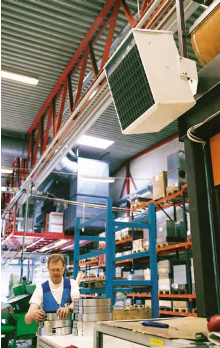
Panther 20-30 -lämpöpuhallin soveltuu suurten teollisuustilojen lämmitykseen.
