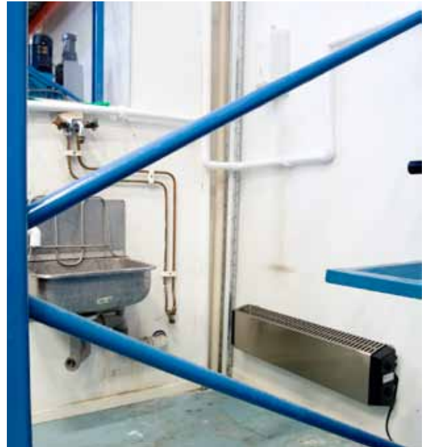
Thermowarmin ruostumattomasta teräksestä valmistettu versio kestää syövyttäviä ympäristöjä.
