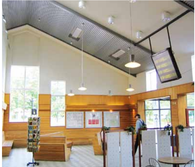
Kauniit puuseinät pidetään vapaina kattoon asennetuilla EZ100-lämmittimillä.
