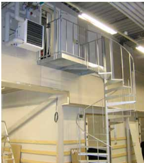
Putkien liitäntäpuoli voidaan vapaasti valita SWH-lämpöpuhallinta kääntämällä. Ilmanohjaimella, jossa on yksilöllisesti säädettävät lamellit, ilmavirta voidaan suunnata tarpeen mukaan.
